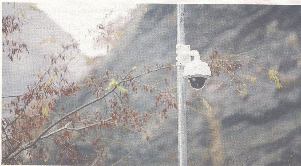
Una delle telecamere di ultima generazione installate a Issogne
